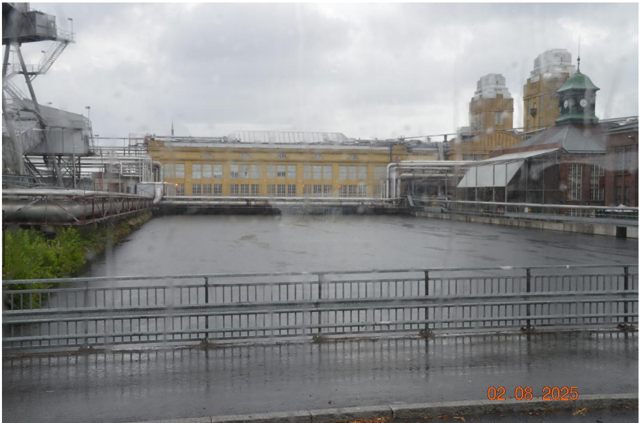
Voimakanavan voimalaitos, jonka putouskorkeus vaihtelee vesitilanteen mukaan 4.5 – 6 m.
